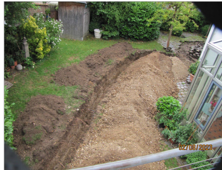
Verlegung der Saugleitung
